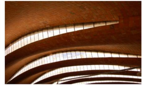
La structure porteuse est visible au plafond, mais cachée par les murs qui ont été recouverts de nouvelles briques à l'extérieur.
