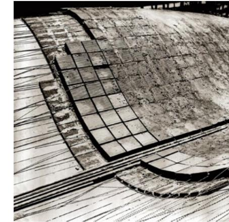
Travaillant dans des conditions économiques plus strictes, Eladio Dieste décide de laisser la structure apparente et de ne pas la recouvrir, évitant ainsi d'utiliser plus de matériaux ou d'éléments comme les poutres et donc d'augmenter le coût de production, donnant ainsi un aspect très innovant à ses oeuvres, dont l'entrepôt Julio Herrera y Obes.
