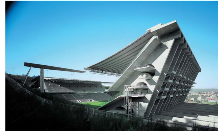
béton, mais a finalement été exécuté avec un système de construction métallique. La canopée, qui est interrompue dans le champ, arrondit ses bords avec des rangées de projecteurs et des tuyaux de drainage pour l'eau, qui est déversée de la falaise à travers des gargouilles dans deux grands canaux sculpturaux en porte-à-faux. Derrière les buts, il n'y a pas de tribunes, laissant la topographie naturelle devenir le protagoniste pendant les matchs de football.
