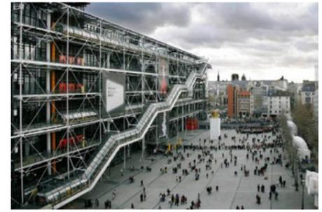
L'idée principale des architectes c'était de faire une construction où tout doit être montré, rien ne doit être caché, alors toute la structure du bâtiment est à l'extérieur, ainsi que tout ce qui le fait fonctionner comme les circulations et les tuyaux.
