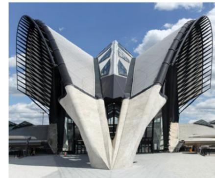
Les deux côtés du hall sont délimités par de hautes parois verticales vitrées qui reposent sur de grands arcs en béton enjambant toute la largeur de la gare. De petits arcs redéfinissent en partie basse l'accès aux déambulateurs et une zone de vitrages mobiles pour l'aération du hall.
