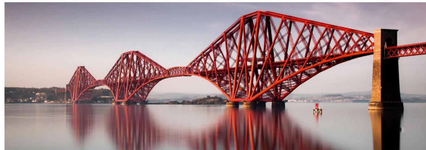
Ce pont ferroviaire est le plus long pont cantilever à travées multiples du monde. Ouvert en 1890, il fonctionne encore aujourd'hui et reste un important pont ferroviaire pour le transport des passagers et des marchandises.
